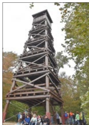
Der rekonstruierte Plesseturm zwischen Wanfried und Hildebrandshausen ist wieder begehbar. Foto: Reiner Schmalzl
